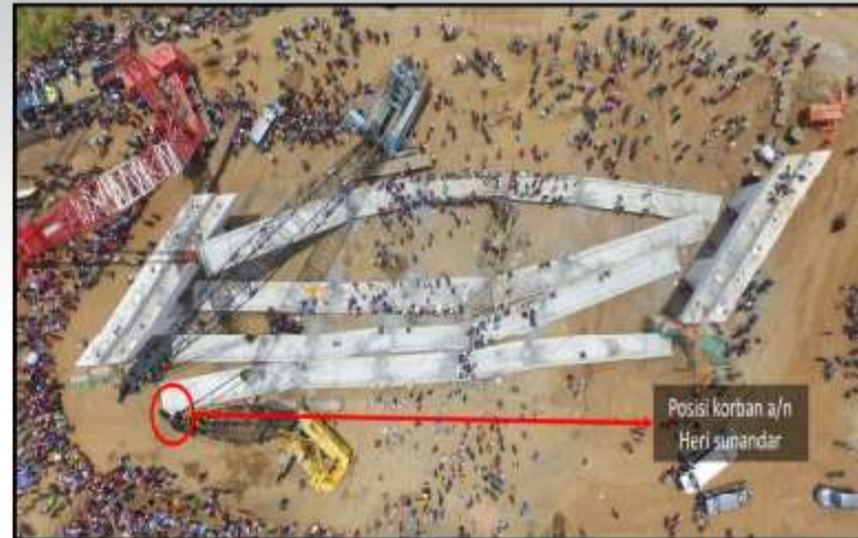
Kondisi Saat Kecelakaan Konstruksi
