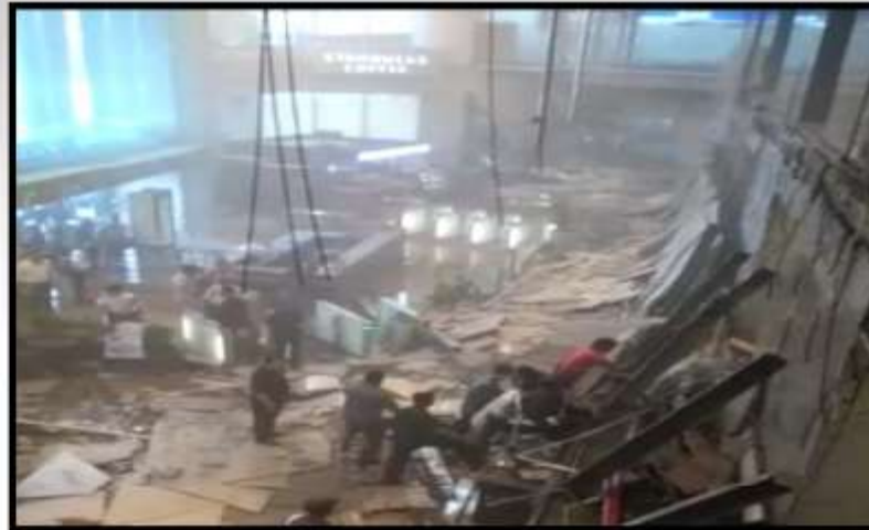
Kondisi Saat Kecelakaan Konstruksi
